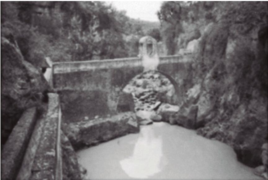
**Ilustración II.2** – El conducto del agua que baja de "La Toma" de la sierra de Tócuaro cruza la cañada y sigue sobre muro vertical (AHA).
