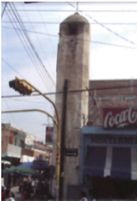
**Ilustración II.12** – Restos de distribuidor para elevar el agua mediante sifón.
