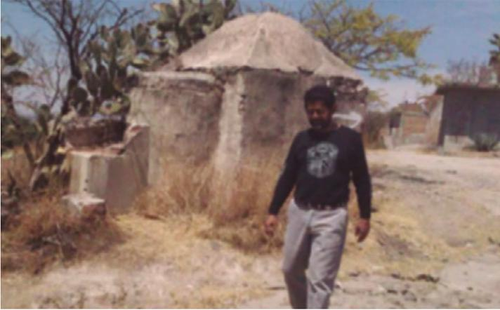
**Ilustración II.4** – Barrio La Laja, trayecto poblado, sin invasión a la ruta del acueducto, construido por caños o ductos bajo tierra, conduciendo el agua en zigzag hacia las “ventosas” o “arcas de agua”.
